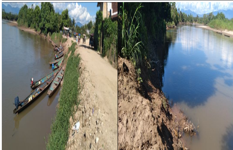
FOTOGRAFIA N°02: SE VISUALIZA LA EROSIÓN DEL BORDO DEL RIO QUE AFECTA DIRECTAMENTE A CARRETERA.
